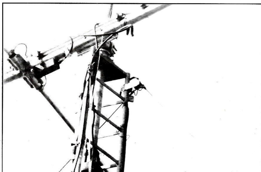
Fixation en haut du pylône.
