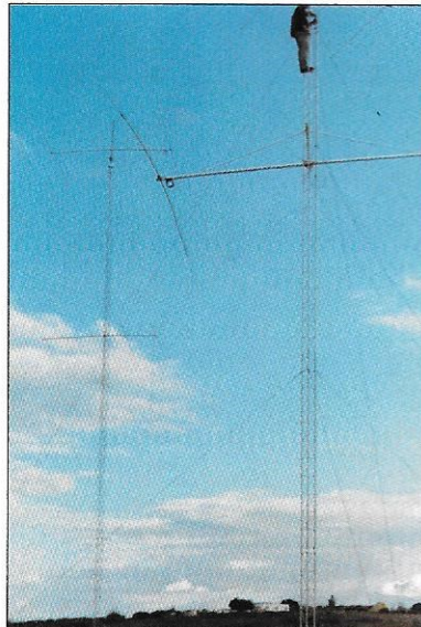
Montage des deux pylônes supplémentaires.
