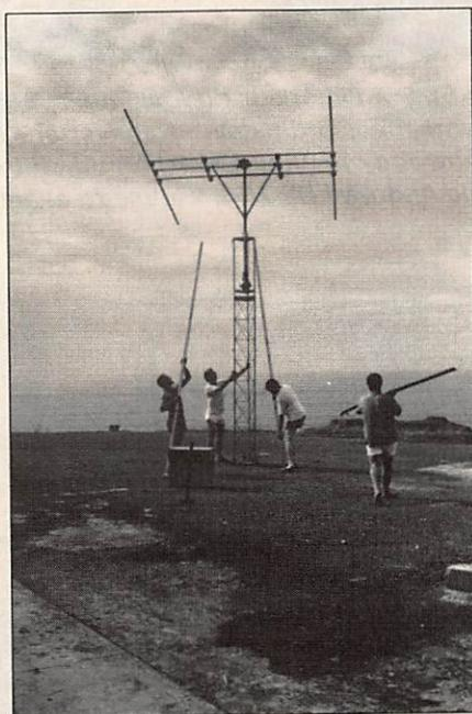
*Montage de la structure support d'antennes.*
