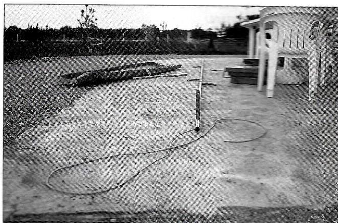
Début de l'assemblage. On voit la sortie du coaxial par le bas du tube.
