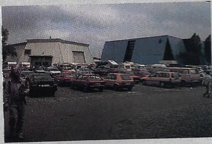
Vue parking intérieur.
