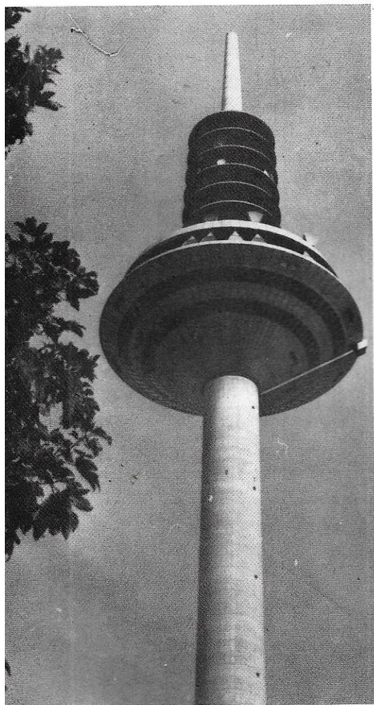
Pylône du centre émetteur de FRANKFURT
