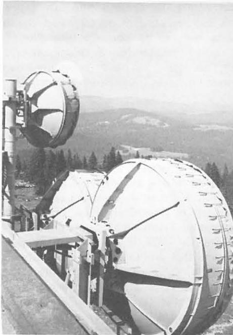
Ci-dessus, un groupe d'antennes paraboliques de faisceaux hertziens. Ils reçoivent les signaux audio-vidéo du centre de production de Genève.
