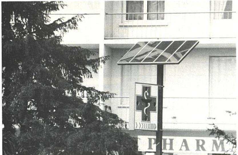
Un système solaire autonome peut se scinder en plusieurs parties, comme en témoigne la **figure 1**. Le panneau solaire, de technologie quelconque, fournit, via un dispositif de régulation, un courant de charge à un accumulateur. Ce dernier assurera la production d'électricité au sous-ensemble que l'on souhaite activer, lors de la disparition du soleil.
