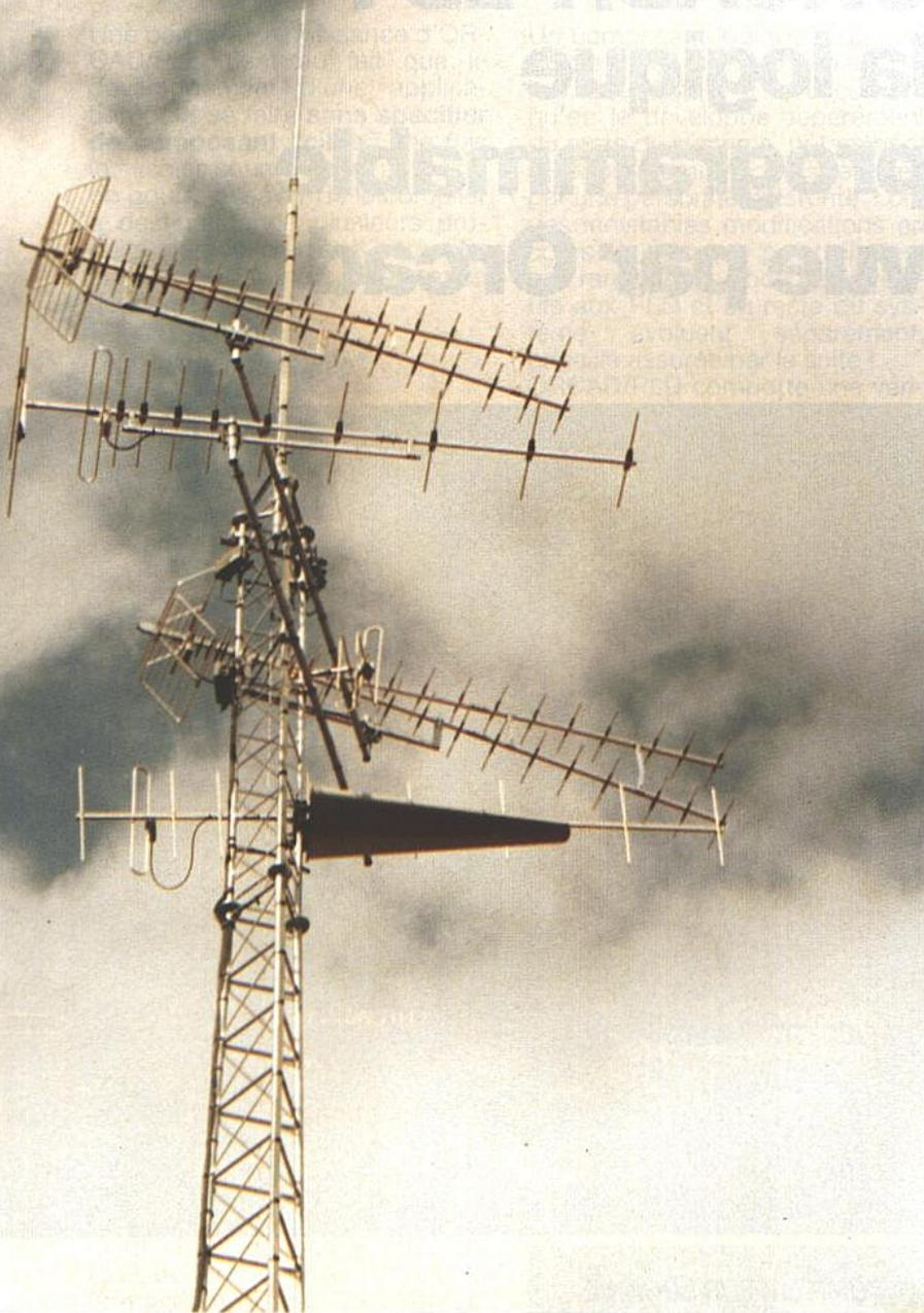
Figure 10 : Le pylône de réception d'une station de tête de réseau câblé (doc. Fuba Communication).
