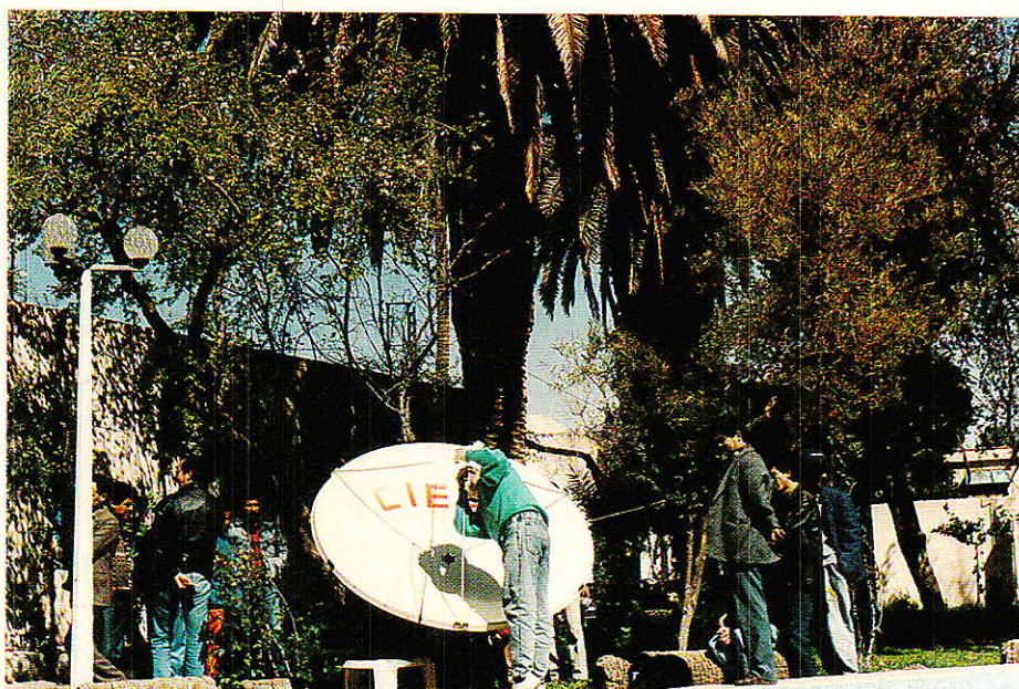
Installation de la tête au foyer de l'antenne.
