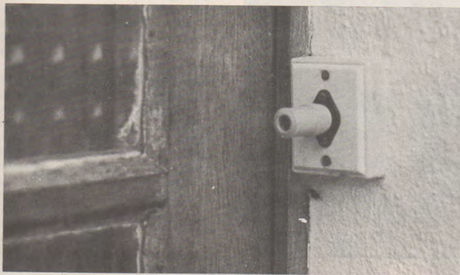
Une disposition possible pour le support de fiche servant de serrure
