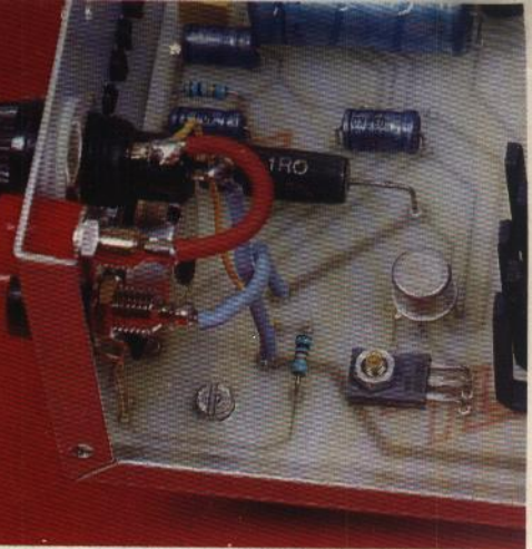
Photo 4. - Le câblage des fiches banane et du fusible.
