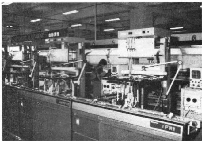
Photo 2. - L'alignement automatique. Les petits bâtons blancs sont des tournevis de réglage qui viennent s'encaster dans les noyaux des M.F.
