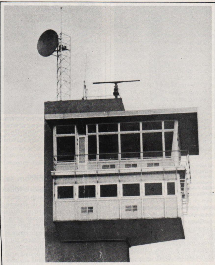
Sur le toit du PCC de l'écluse François-1<sup>er</sup> sont montés le radar Raythéon et l'antenne du faisceau hertzien TV transmettant les images traitées au centre de contrôle.
