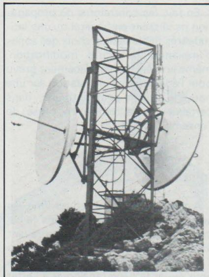
Photo 1. - Relais passif de Lesquerdes. Situé sur la liaison Perpignan-Saint-Paul-de-Fenouillet, dans la commune de Lesquerdes, à 546 m d'altitude, ce relais passif a été mis en service en 1970. Il se compose de deux antennes dirigées l'une sur Perpignan, l'autre sur Saint-Paul-de-Fenouillet. (Cliché DTRN).
