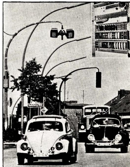
dants. L'installation représentée sur la photo se compose d'un ensemble de radars **Telefunken** et d'un calculateur électronique de la **Standard Elektrik Lorenz**. Ce dernier travaille en choisissant le programme de commutation le plus favorable parmi tous ceux dont il dispose, et qui ont été déterminés expérimentalement par une étude approfondie de toutes les situations possibles d'une circulation. — **Telefunken-France**, 37, r. de la Chine, Paris (20<sup>e</sup>).
