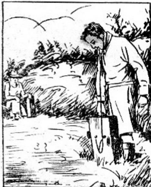
A gauche : l'opérateur émetteur envoie des ondes verticales dans le sol dans le but de les faire se réfléchir sur une nappe métallique. A droite : l'opérateur récepteur cherche l'« écho » de ces ondes.
