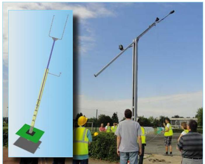
Pour estimer le potentiel de production d'énergie électrique du site, il a fallu concevoir et installer un mât de mesure de vitesse et de direction du vent.
