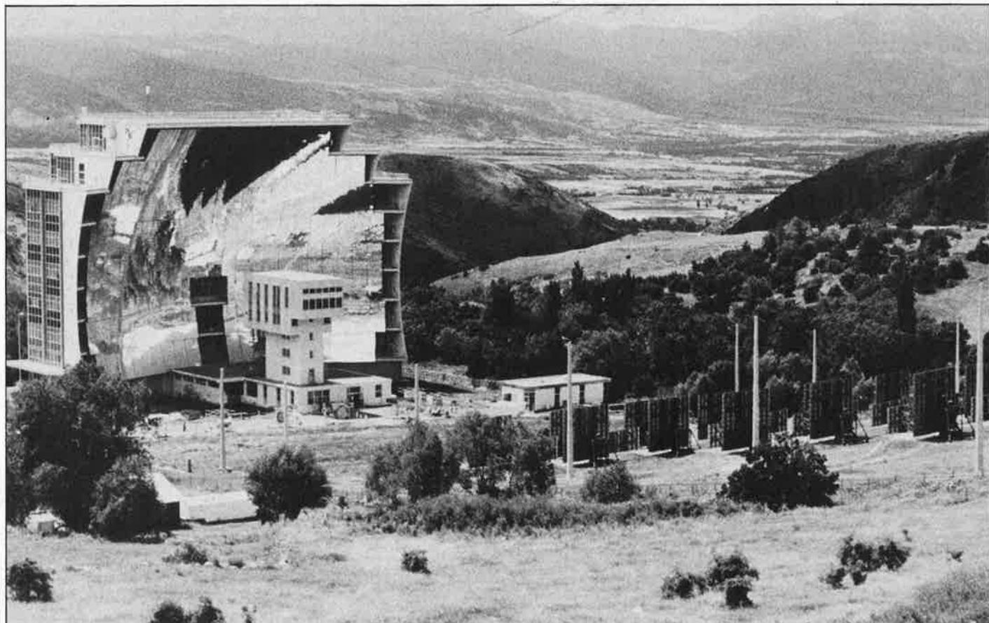
miroirs héliosynchrones montés sur des supports articulés pour leur permettre de suivre le soleil dans sa course à travers le ciel (figure 3). Bien entendu, la complexité d'une telle installation en limite l'usage aux grandes centrales et aux fours solaires. Le rendement obtenu atteint couramment 30 %.
