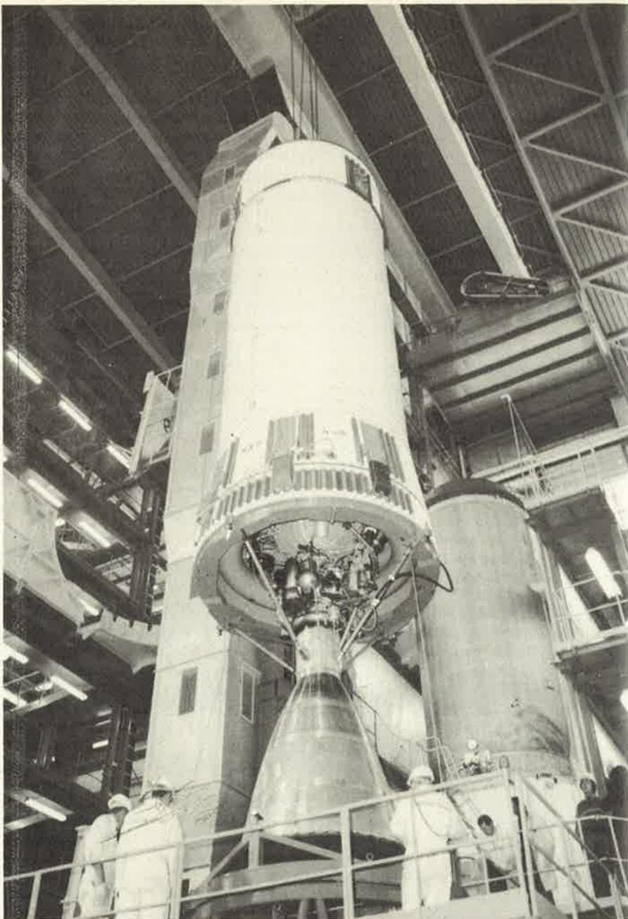
Le moteur SEP Viking du 2ème étage est muni d'un grand divergent galbé en coquetier réalisé en alliage de Cobalt.
