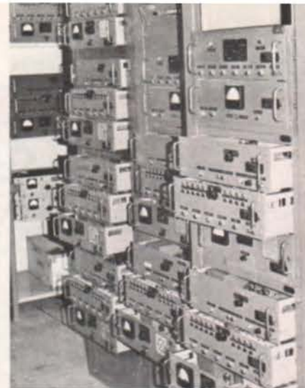
PHOTO E: Salle des émetteurs VHF située de l'autre côté de la piste. Il n'existe, au service contrôle aérien, que la B.F. que l'on pourrait schématiquement représenter par un microphone et un haut-parleur. Toute la partie émission et réception est disposée près de la piste, dans deux bâtiments espacés de 2 km pour éviter les interférences. Les émetteurs représentés sur la photo sont en train d'être réformés et seront bientôt remplacés par des ensembles à transistors.
