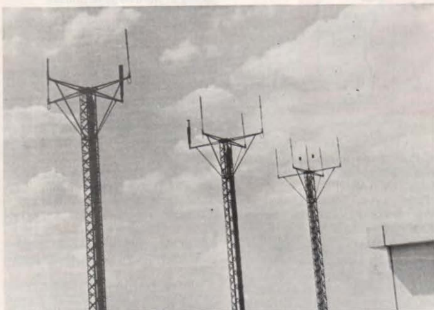
PHOTO H: Antennes VHF érigées tout à côté du bâtiment «émission».
