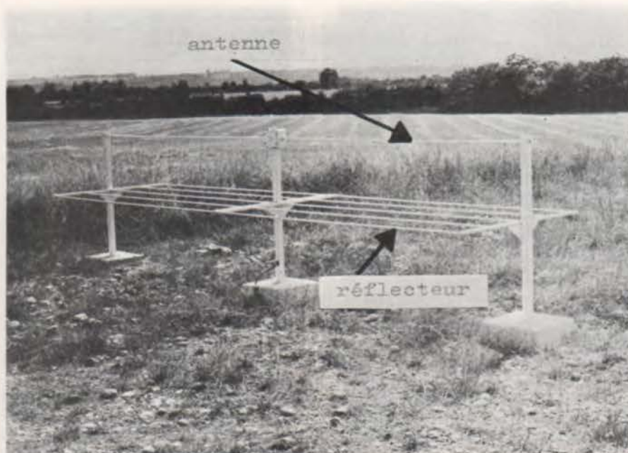
PHOTO J : L'antenne de la balise de Satolas qui produit dans l'espace une espèce de cône radio-électrique.
