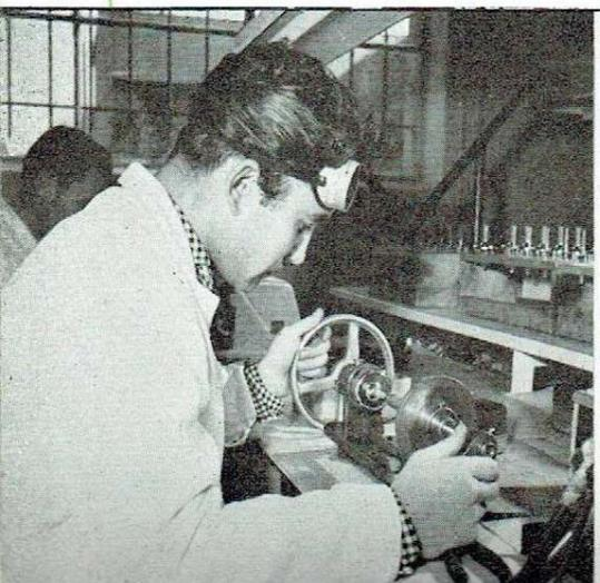
Contrôle au pyromètre optique de la température d'anode lors du dégazage.
