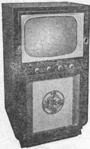
Console 54. Tube de 54 cm. Monocanal. Dimensions : H1140-L670-P650 mm.
