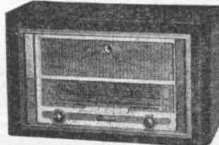
**RB33.** 6 lampes (6AJ8, 6BA6, 6AV6, 6BQ5, 6V4, EM34). 4 gammes PO-GO-OC-BE. Cadre à air blindé. Clavier 6 touches dont commutation antenne-cadre, et PU. HP 17 cm. Tonalité réglable. Ebénisterie noyer. H290-L475-P215 mm. Prix T.T.C. 29.205
