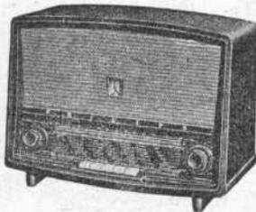
**BF 460A.** 5 lampes (ECH81, EBF80, ECL82, EZ80, EM80). 4 gammes BE - OC - PO - GO. Cadre ferrocapteur, et antenne OC incorporée. Clavier 5 touches dont 1 arrêt-secteur, et combinaisons par 2 touches pour gamme Chalutier (adaptable sur demande) et commutation PU. HP 16 cm. Tonalité réglable. Polystyrène bordeaux ou ivoire, H270-L385-P180 mm.
