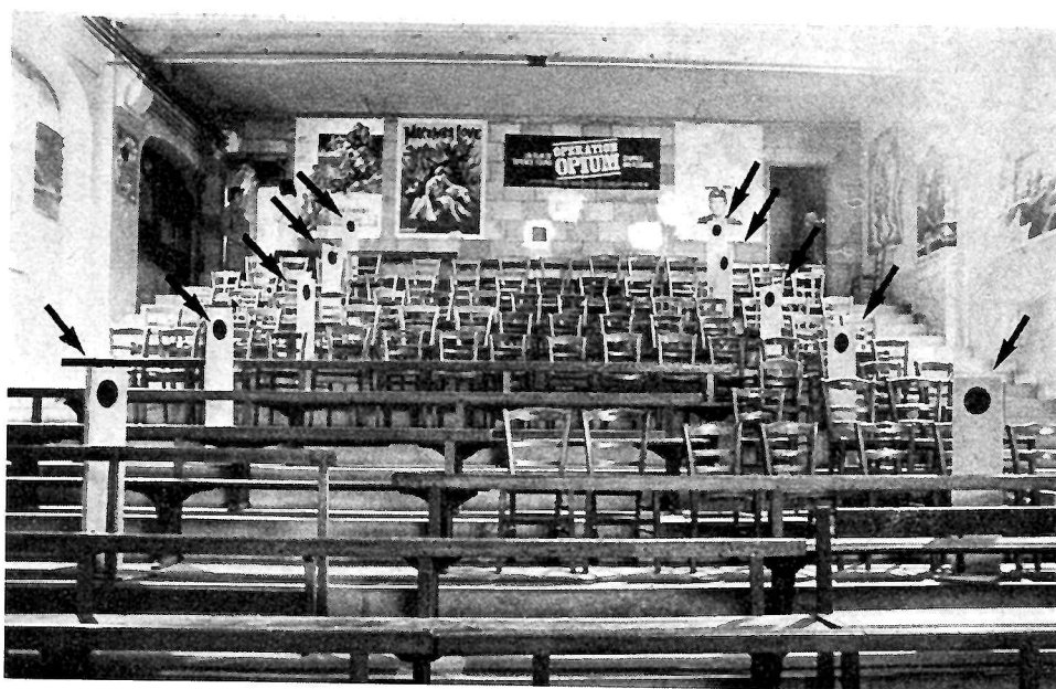
Fig. 4. — Exemple de traitement d'une salle réverbérante. Cette salle en gradins de béton, destinée au cinéma et au théâtre, constituait un cas-limite désespéré. La solution a été apportée par ces rangées de haut-parleurs (flèches) en cours d'installation, émettant sur leurs deux faces à petit niveau, et assurant une excellente intelligibilité.
