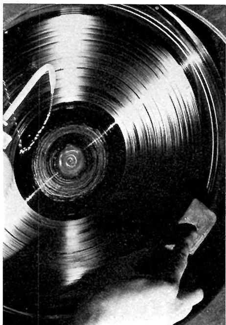
Fig. 8. — Nettoyage d'une matrice
