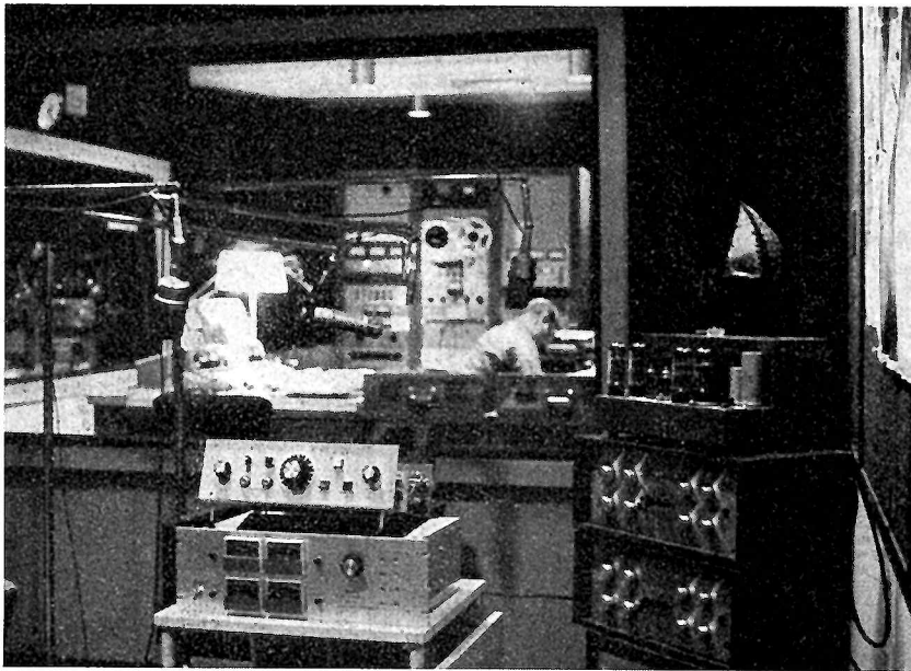
Les studios de radiodiffusion s'intéressent aux procédés de diffusion quadriphonique. On voit ici (en bas de la photo) le codeur/décodeur SANSUI QS en expérimentation.
