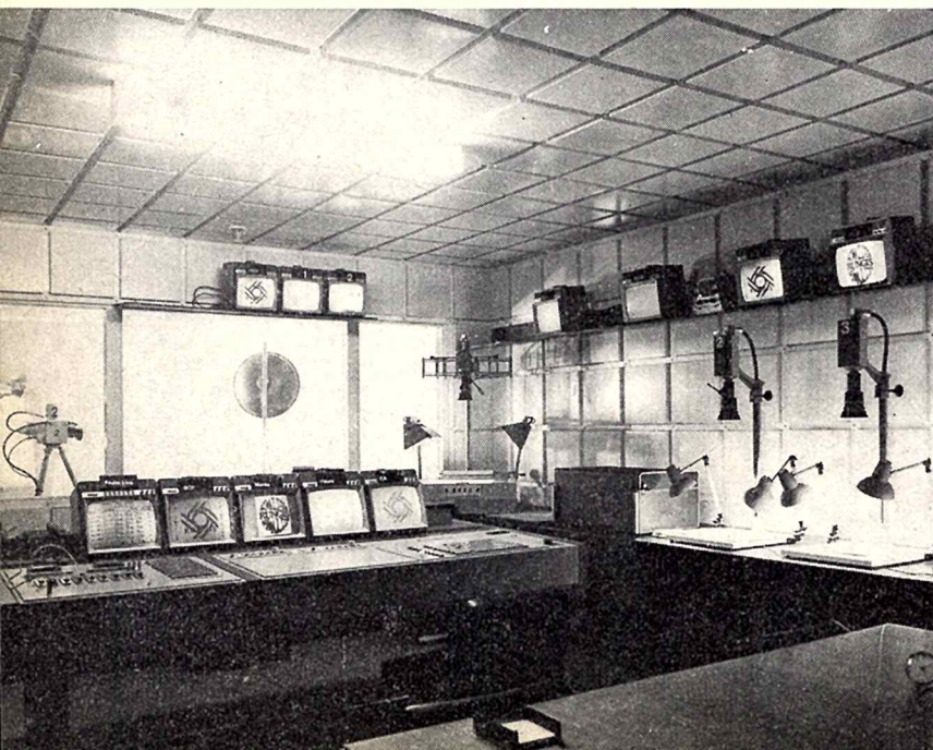
Fig. 1. — Installation de télévision privée réalisée par la Compagnie des Compteurs aux nouvelles halles de Rungis : la salle de régie.
