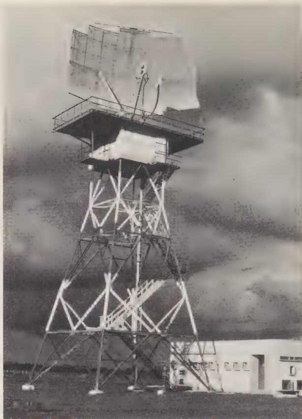
Fig. 1. — Antenne d'un radar primaire à longue portée L8 23, surmontée de l'antenne AS 309 d'un radar secondaire RS 770 (TVT, installation au Brésil).
