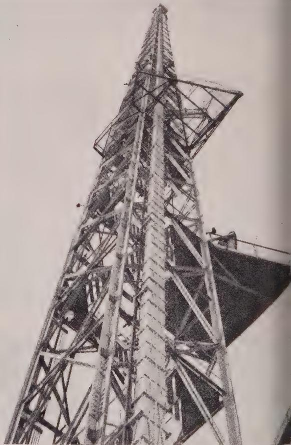
FIG. 4. — Pylône de Bouvigny (Nord). Hauteur environ 300 m (on distingue nettement la colonne de guide).
