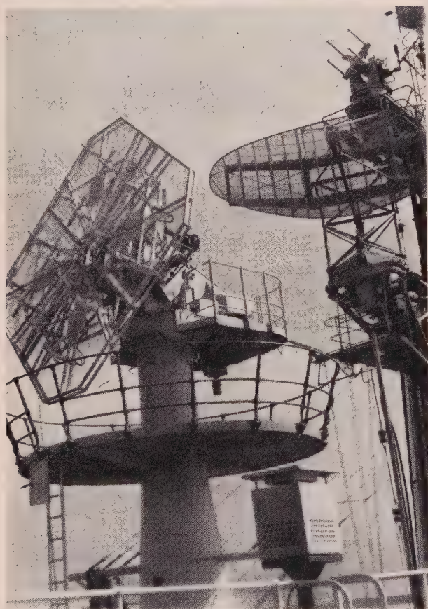
FIG. 10. — Aérien de télémessure sur son piédestal à monture théodolite. a) Antenne en cours d'essais à Riom. b) Antenne en place sur le Henri Poincaré.
