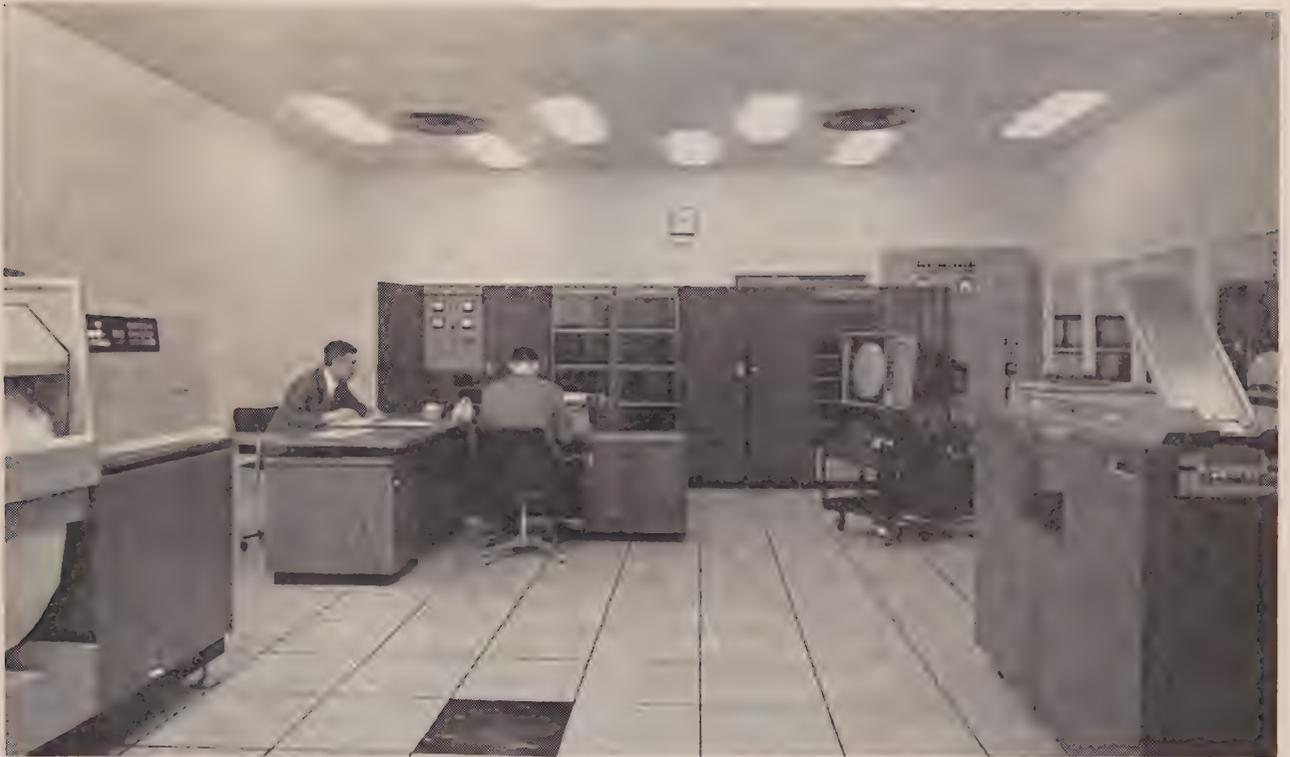
Imprimante rapide, calculateur TR 4 Telefunken et son pupitre de contrôle, indicateur de contrôle Plessey, perforatrice de carte.
