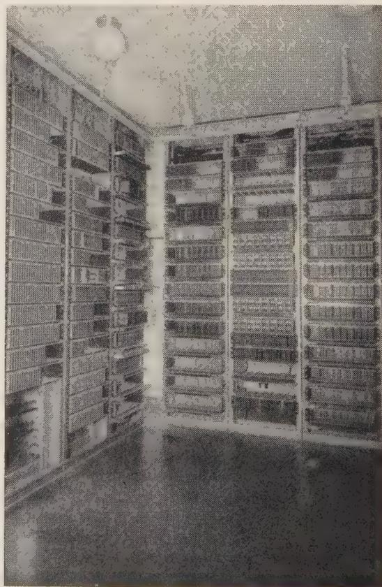
FIG. 28. — Réseau de connexion équipé à 2 500 lignes.
