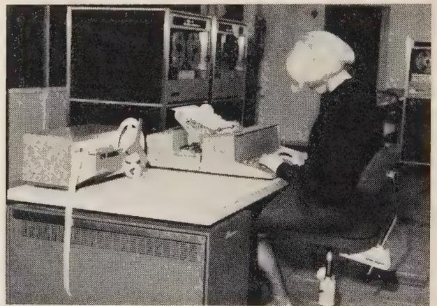
Calculateur IBM 1 401, équipé d'un lecteur de bandes Facit PE 1 000.
