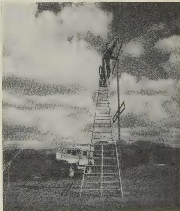
FIG. 3. — Installation d'une antenne de riomètre aux îles Kerguelen, pour les observations pendant les AISC (Photo Dassonville).
