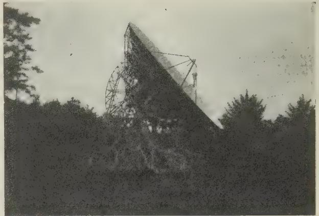
FIG. 1. - Radiotélescope de 10 mètres de diamètre, destiné à l'observation des radiosources à 3 750 et 9 400 MHz. Institut de Recherches de Toyokawa (Japon).
