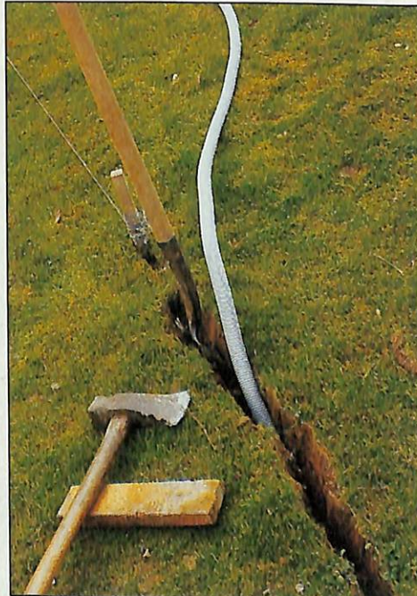
Comment enterrer discrètement un câble : une bêche, une cale en bois et une masse...
