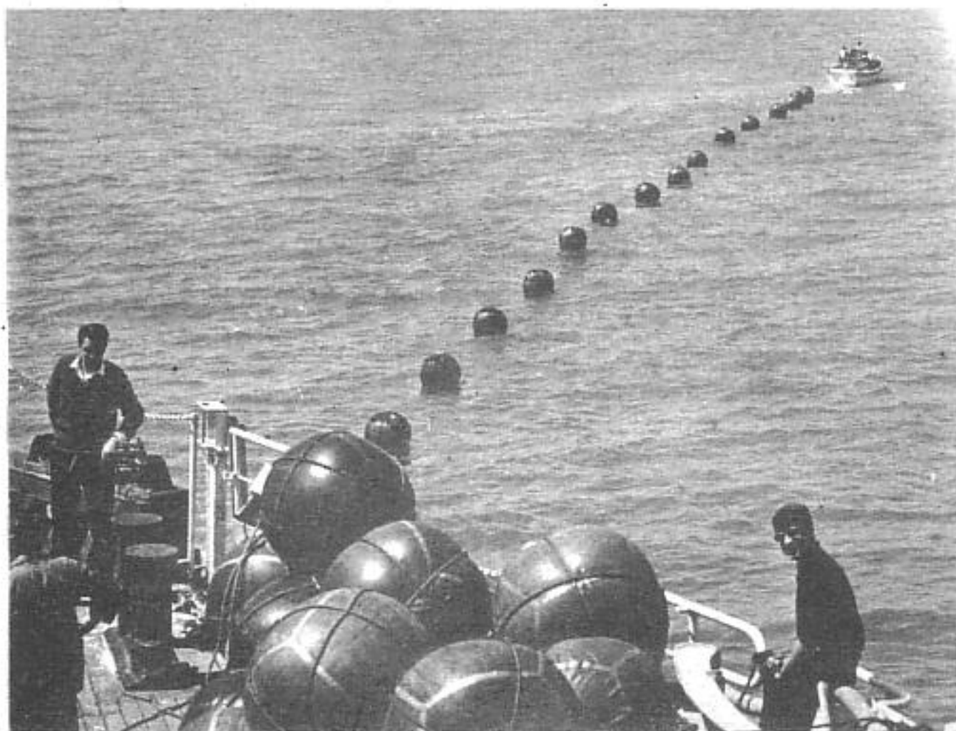
La pose des atterrissements par le navire français « Marcel Bayard »: un canot à moteur tire l'extrémité du câble en direction de la côte; pour éviter que celui-ci traîne sur le fond et faciliter ainsi sa traction des hommes de l'équipage y attachent, tous les 8 m environ un ballon servant de flotteur.
