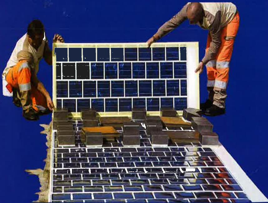
La société Colas effectue des tests en France sur une route photovoltaïque, appelée Wattway. Elle est constituée de panneaux solaires basés sur une technologie qui les rend indestructibles grâce à une résine spéciale qui recouvre le revêtement sur lequel circulent les véhicules. Ainsi la surface de la route produit de l'énergie sans occuper d'espace supplémentaire.
