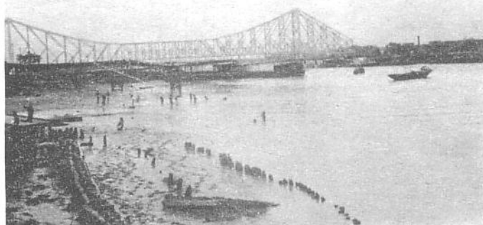
Fig. 3 - Le grand pont sur le Gange vu des Burning Ghats.
