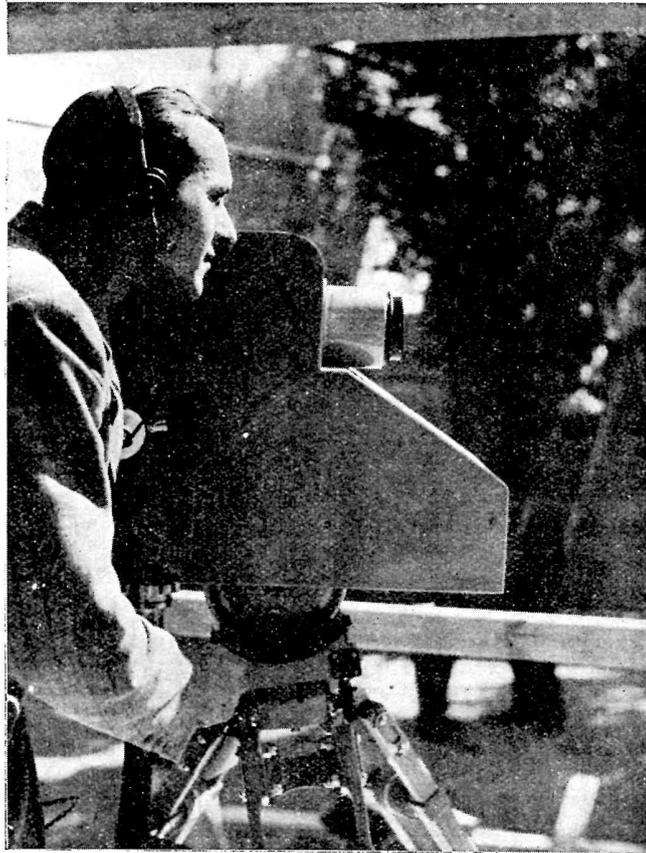
Fig. 2. — Camera électronique à prise de vue directe (Telefunken)
