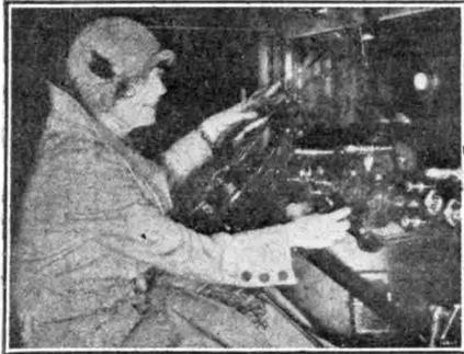
Fig. 1. — Sur la planche de bord de cette automobile américaine, un poste récepteur radiophonique est disposé, et permet l'audition des radio-concerts même pendant la route. Ce poste est alimenté par les batteries de la voiture et par une batterie de piles de tension plaque ; un collecteur d'ondes est dissimulé dans la carrosserie et un haut-parleur fixé à l'arrière.
