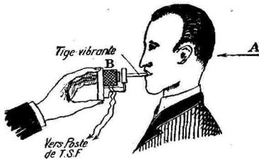
Fig. 5. — Si un sujet de bonne volonté A, serre entre ses dents la tige vibrante B, d'un moteur électromagnétique de haut-parleur, il peut entendre le radio concert, même s'il est sourd, et sans que les personnes qui se trouvent autour de lui puissent entendre en même temps.
