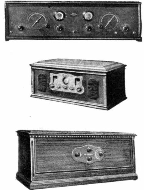
Fig. 4. — Deux postes américains à étages haute fréquence à résonance comportant des organes de réglage groupés sur un « tabletier » de commande et une superhétérodyne classique.
