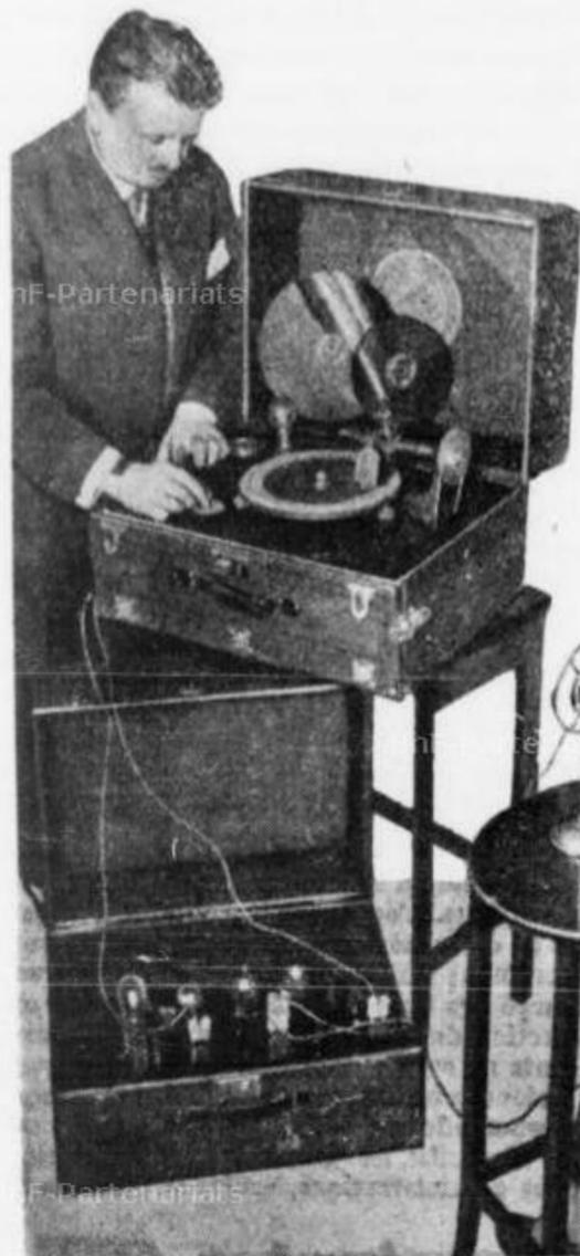
Une installation portable d'enregistrement : au premier plan les microphones ; sur le sol, la valise d'amplification ; sur la table, la valise d'enregistrement (Galliavox).
