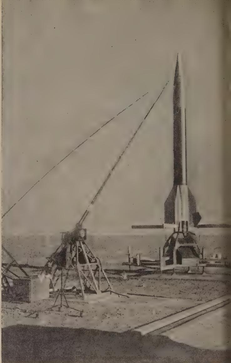
FIG. 5. — Des prises spéciales situées sur la « peau » de la fusée amènent à la charge utile les différents fils de commande, supervision, alimentation nécessaires à la mise en œuvre et au contrôle des équipements de bord avant le départ.
