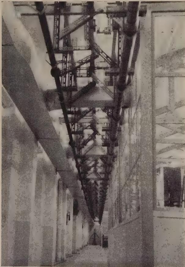
FIG. 9. — Lignes expérimentales formées de guides d'ondes circulaires.
