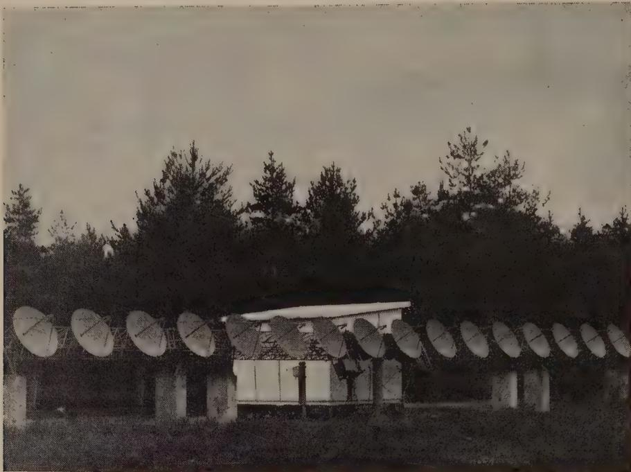
FIG. 3. — Le réseau E-O à 16 antennes, sur  $\lambda = 3$  cm de la Station de Nançay.
