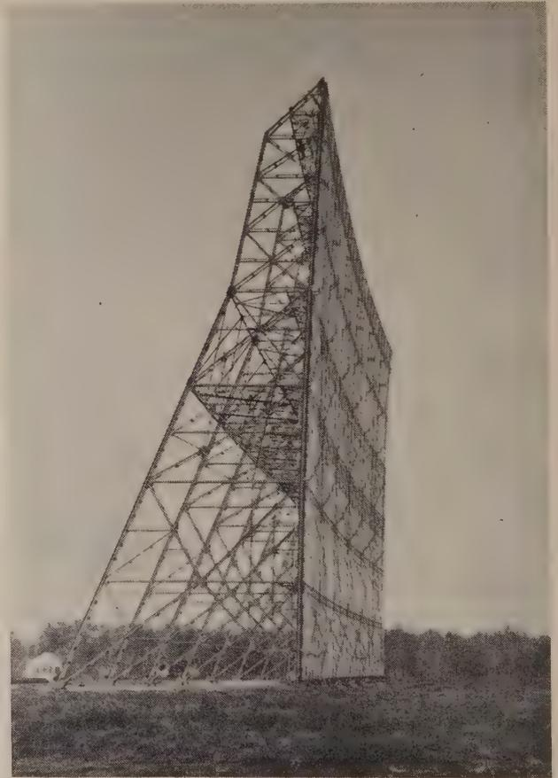
FIG. 10. — Le miroir sphérique : partie prototype achevée ( $35 \times 60$  m)
