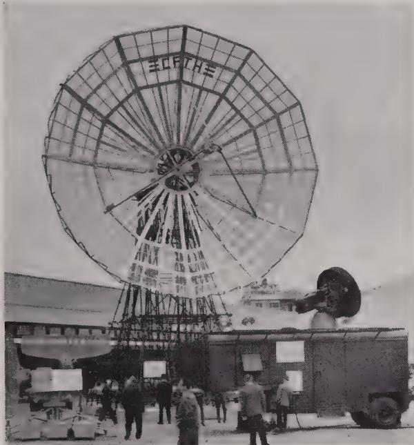
FIG. 3. — Aérien pour équipement de faisceaux hertziens transhorizon C.F.T.H. type GDT 101.
