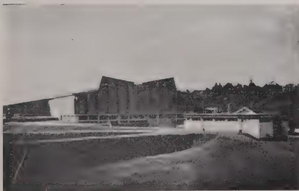
FIG. 26. — Synchrotron du CERN. On voit ici le centre de l'accélérateur où est construit un petit bâtiment. On distingue les remblais de terre qui recouvrent huit tunnels radiaux servant aux visées de triangulation et au passage de câbles. Au fond, le hall d'expérimentation. Derrière lui, une colline artificielle apparaît à droite ; elle empêche les particules rapides servant aux expériences d'atteindre les villages environnants.
