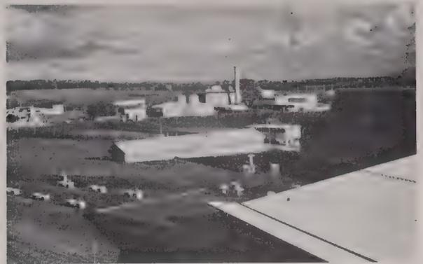
FIG. 27. — Synchrotron du CERN. Vue prise de la colline de protection près du hall d'expérimentation. Ce dernier apparaît en premier plan à droite. Le toit plat, en bas est celui du pré-injecteur de l'accélérateur linéaire. On devine le remblai de terre circulaire qui recouvre le tunnel du synchrotron. Au milieu de ce remblai, deux bâtiments situés au centre de l'accélérateur.
