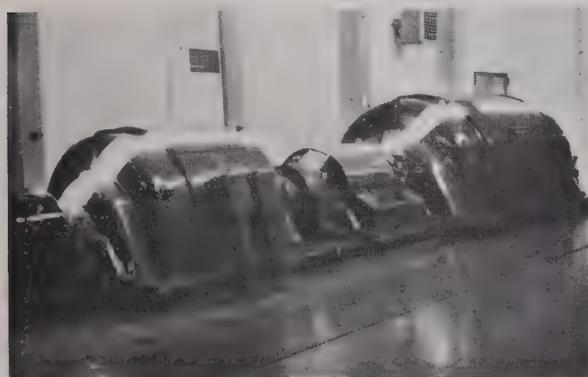
FIG. 22. — Alimentation des électro-aimants. Pour une accélération jusqu'à 25 GeV la puissance de crête absorbée dans les électro-aimants à la fin du cycle est de 27 000 kW et la puissance moyenne 1 500 kW. Pour éviter des à-coups sur le réseau électrique de distribution, la puissance est fournie aux électro-aimants par un alternateur couplé à un volant mécanique lui-même entraîné par le réseau. On voit ici cette installation : moteur volant alternateur.
