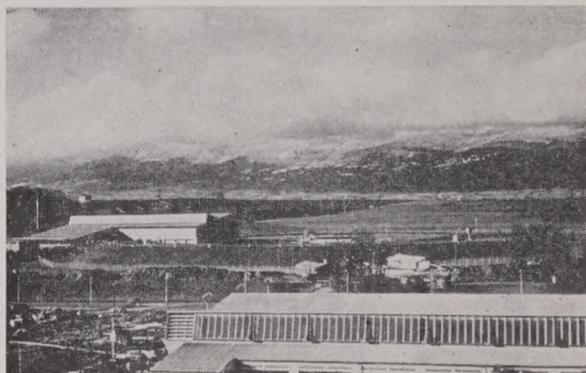
FIG. 1. — Le Synchrotron du CERN. Vue d'ensemble. Au deuxième plan on aperçoit le remblai circulaire de 200 m de diamètre qui recouvre le tunnel abritant le synchrotron. Le bâtiment à gauche est celui des halls d'expérience actuels. Dans le fond la chaîne du Jura.
