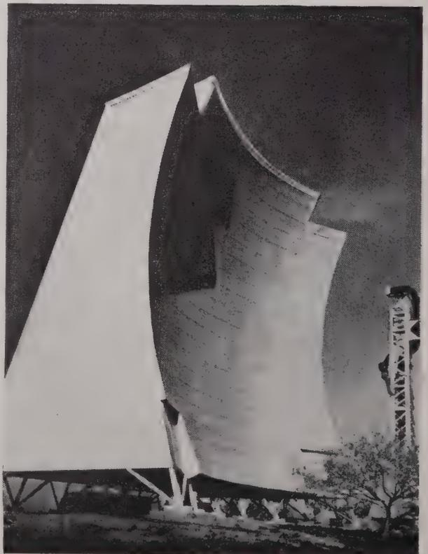
Fig. 9. — Antenne de 20 mètres de la liaison Floride-Cuba de télévision.
