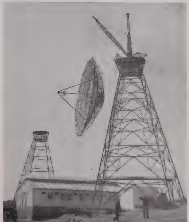
FIG. 5. — Hissage d'une parabole de 10 mètres sur pylône.
