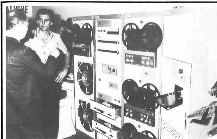
Photo 3. - Station radio automatique pilotée par ordinateur...
